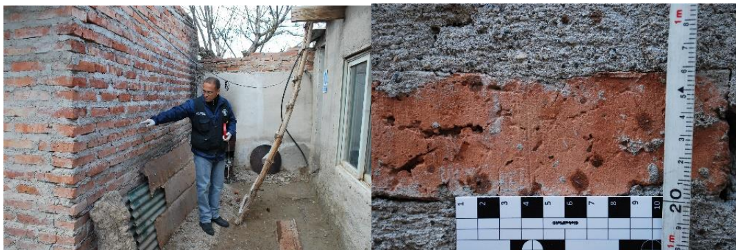
Foto 5: Manchas en pared en zona de descuartizamiento
